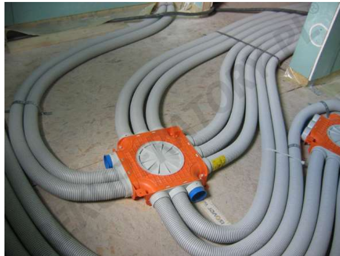
Instalacja rekuperacji 1. ze stali na poddaszu nieużytkowym; 2. z przewodów polietylenowych R-vent Flex przed zalaniem posadzki; 3. NeoFlex z przewodów PE i stali ułożona pod sufitem
