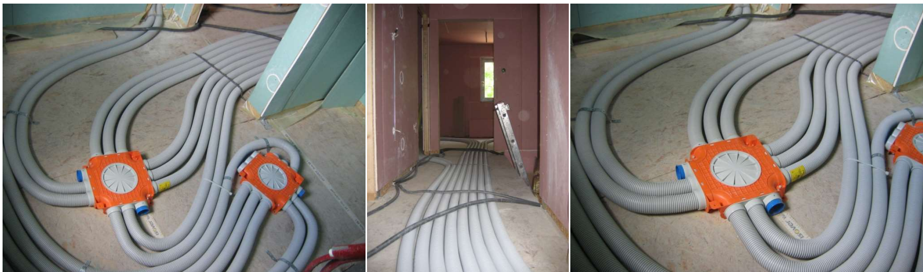
Instalacja wykonana w systemie R-vent Flex z wysokiej jakości przetworzonego polietylenu o średnicy 64 mm pozwala na zalenie instalacji rekuperacji w posadzce.
