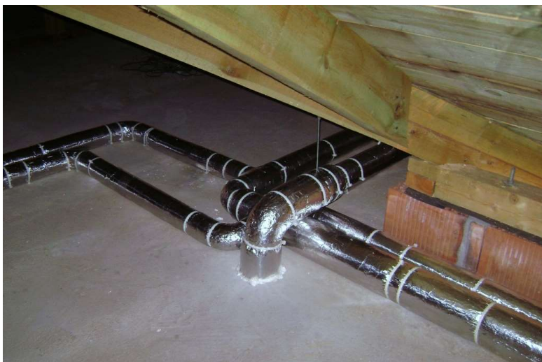
Instalacja rekuperacji 1. ze stali na poddaszu nieużytkowym; 2. z przewodów polietylenowych R-vent Flex przed zalaniem posadzki; 3. NeoFlex z przewodów PE i stali ułożona pod sufitem
