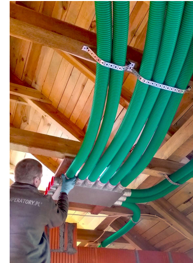
Instalacja rekuperacji 1. ze stali na poddaszu nieużytkowym; 2. z przewodów polietylenowych R-vent Flex przed zalaniem posadzki; 3. NeoFlex z przewodów PE i stali ułożona pod sufitem
